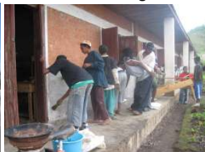
Renovierung einer Schule
